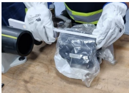
Figura 14. Măsurarea fittingului de PEHD
