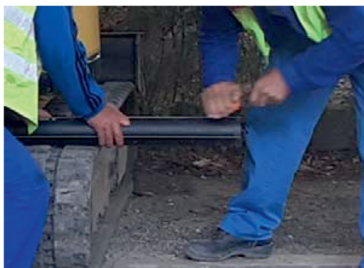
Figura 19. Rașchetare cu dispozitive improvizate
