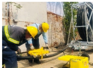
Figura 12. Dezovalizare țeavă PEHD utilizând tamburul derulator și dispozitivul de îndreptat și dezovalizat
